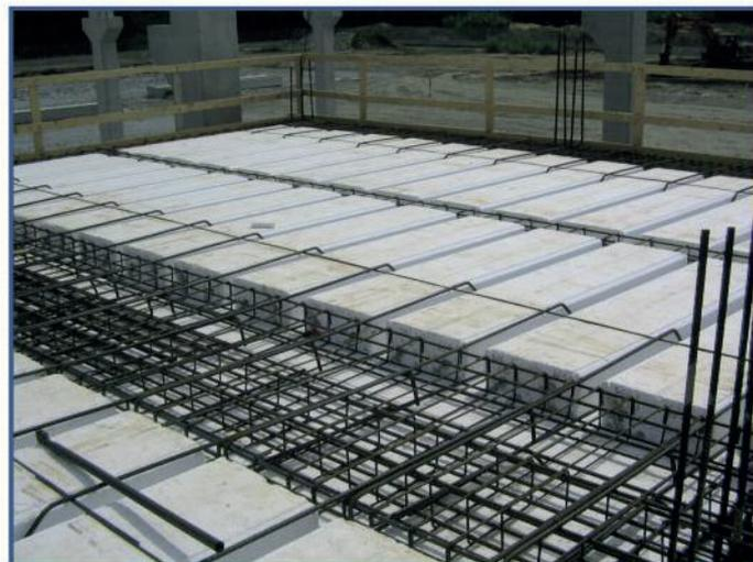
È realizzato in polistirene espanso sinterizzato con la forma della pignatta in laterizio ad altezza
