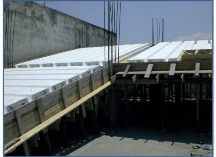
ferenti misure. La continuità dello strato di polistirene all'intradosso del pannello garantisce un ottimo isolamento termico.
