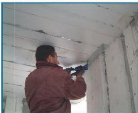
Fissaggio a soffitto su canalina a "L"
